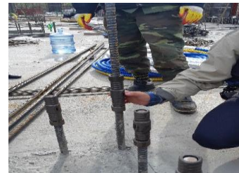
[5.이음철근 접속 후 커플러 체결]
